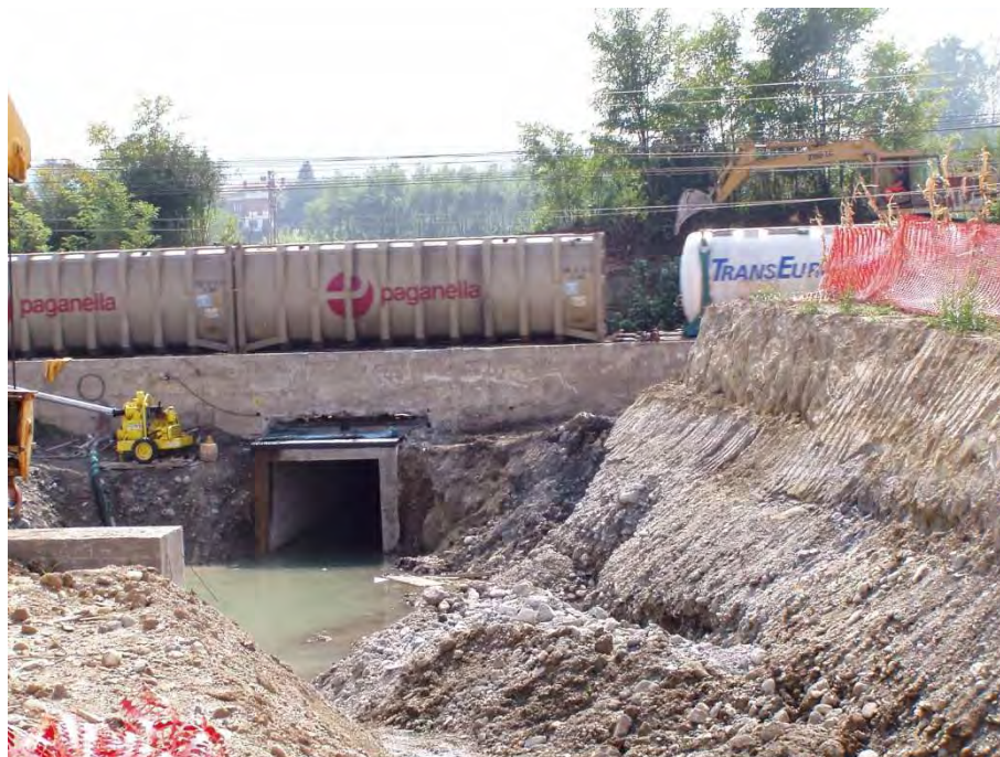
Zona stazione, acqua di falda proveniente dalla collina e drenata dalla falda superficiale, 30 m sopra i livello della Dora Riparia.
